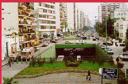
Viaducto Carranza _ CABA
